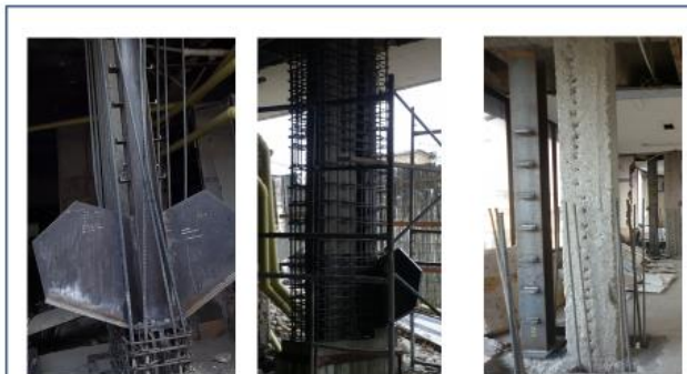
REFORZAMIENTO COLUMNAS CON ESTRUCTURA METALICA
