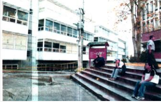
BLOQUE A DEMOLICIÓN
