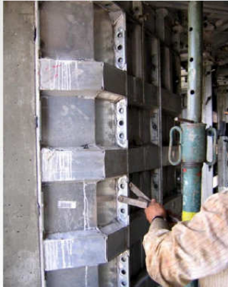
Desmontaje de las formaletas
